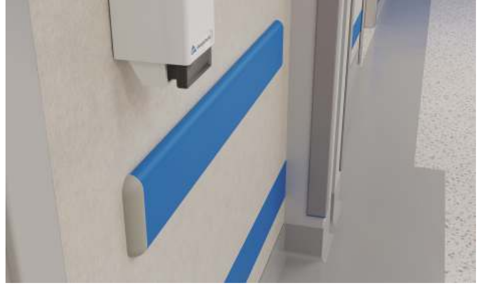
Duvar Yüzeyleri Wall Surfaces
