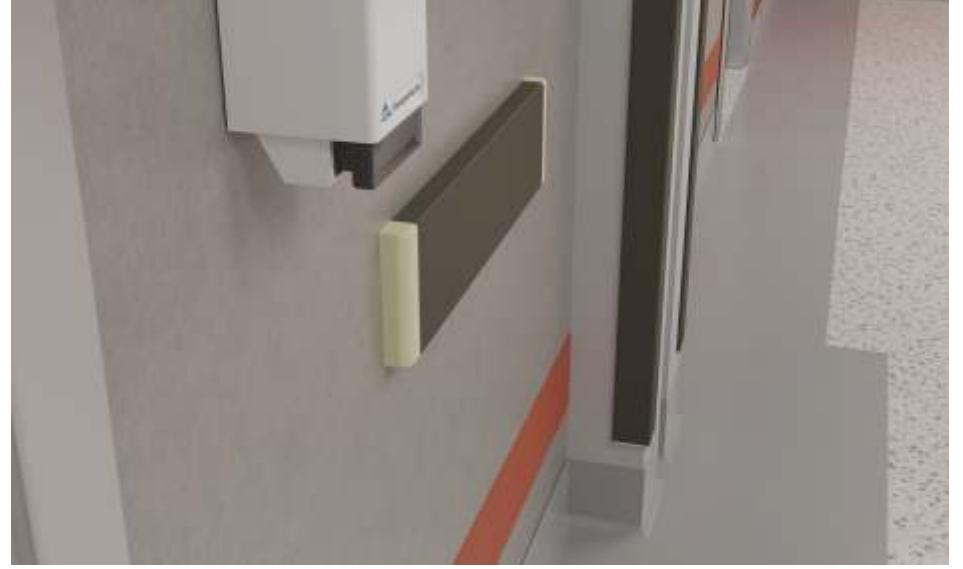
Duvar Yüzeyleri Wall Surfaces
