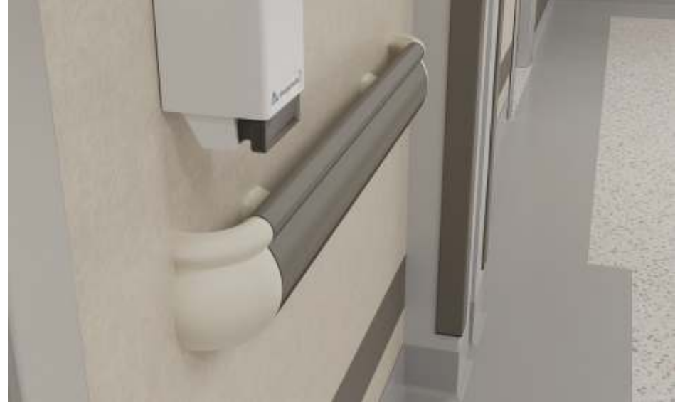
Duvar Yüzeyleri Wall Surfaces
