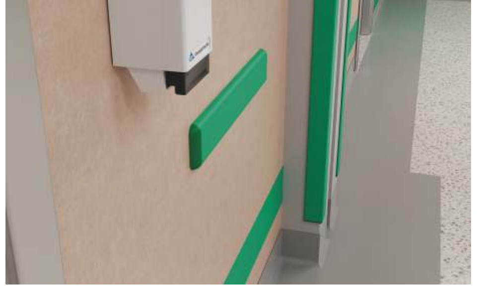
Duvar Yüzeyleri Wall Surfaces
