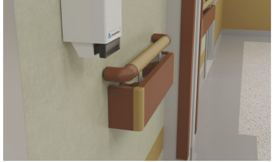
Duvar Yüzeyleri Wall Surfaces
