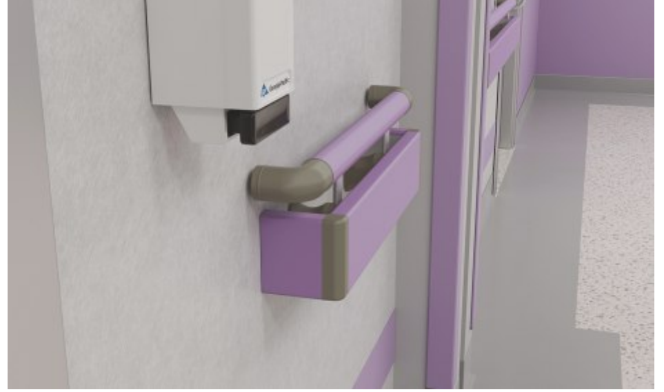
Duvar Yüzeyleri Wall Surfaces
